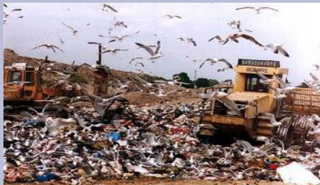
Falta de aterro
